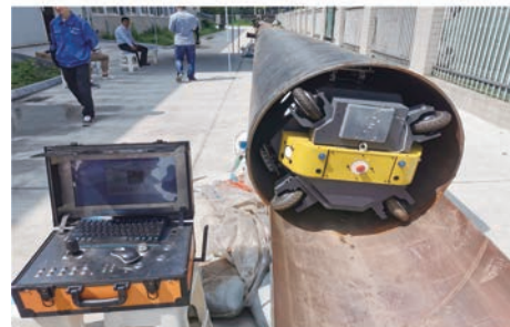
(c) 管道机器人实地测试
